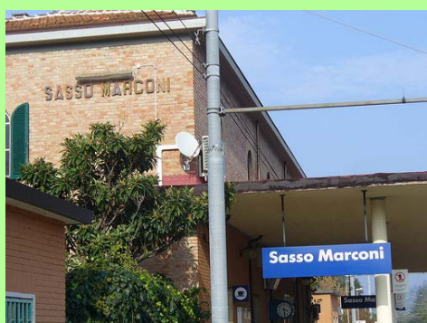
foto di Tolomelli M. - Stazione di Sasso Marconi
