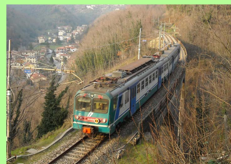
foto di Pacini S. - Viadotto di Fabbriacaccia
