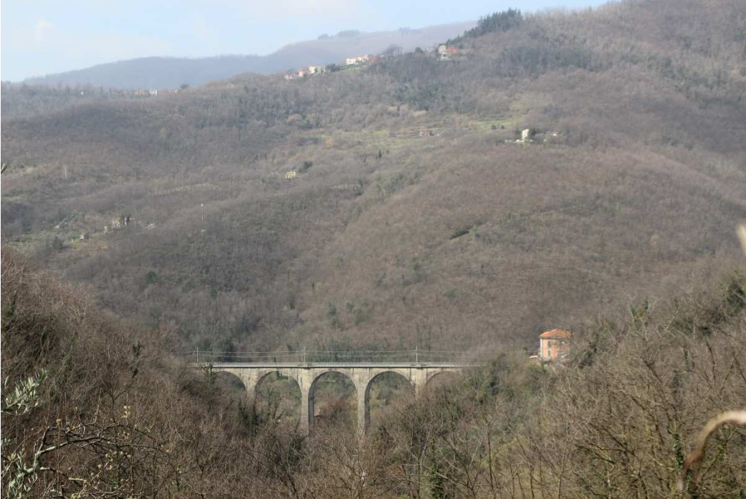
Viadotto di Piteccio
