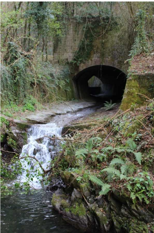
Galleria idraulica e deviazione del torrente Castagno
